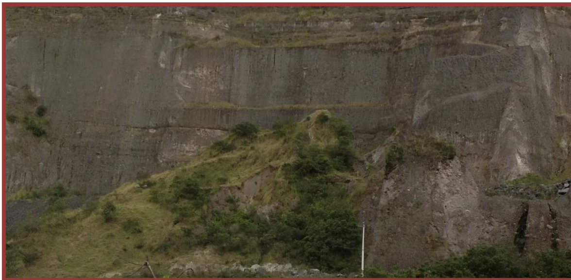
Figura 27: Apertura de vía Lloa - San Jose.
