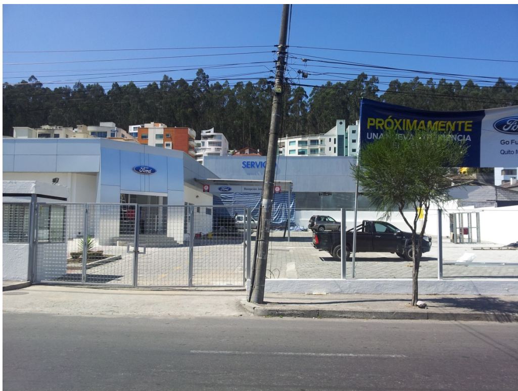
Fotografía 1: Nuevas instalaciones Quito Motors Ag. Granados y Motilones
