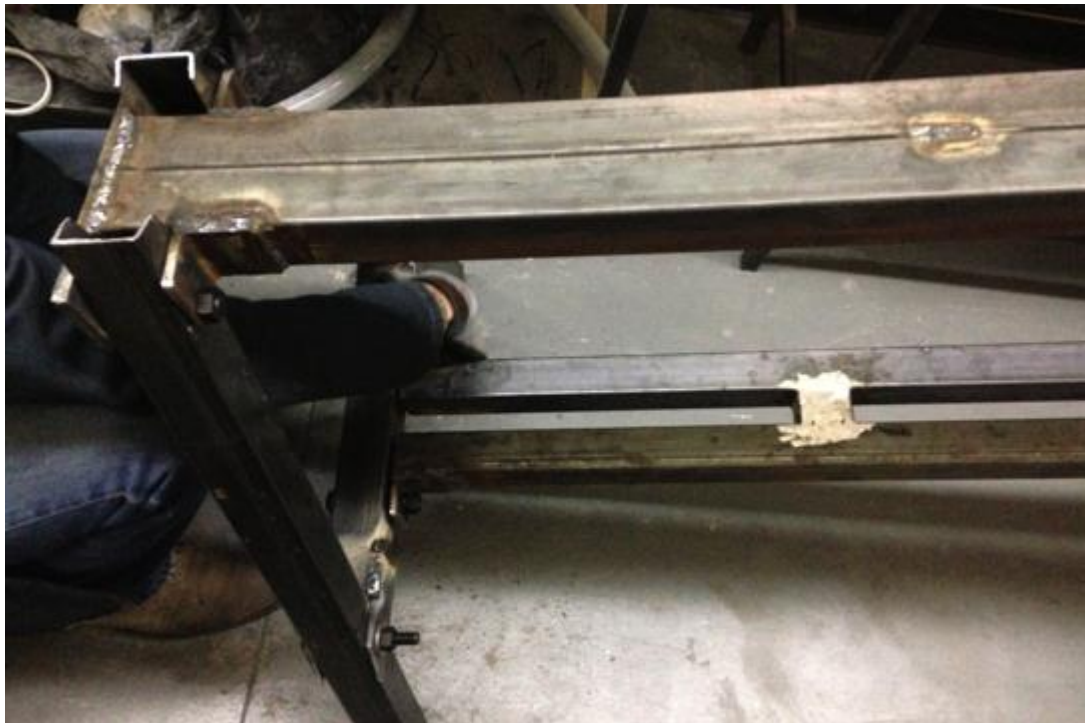
Figura 37.- Colocación del soporte del pistón a la estructura.
