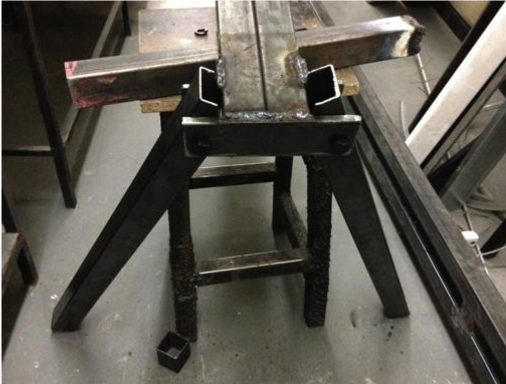
Figura 34.- Colocando los perfiles de apoyo para la pista de la plataforma.
