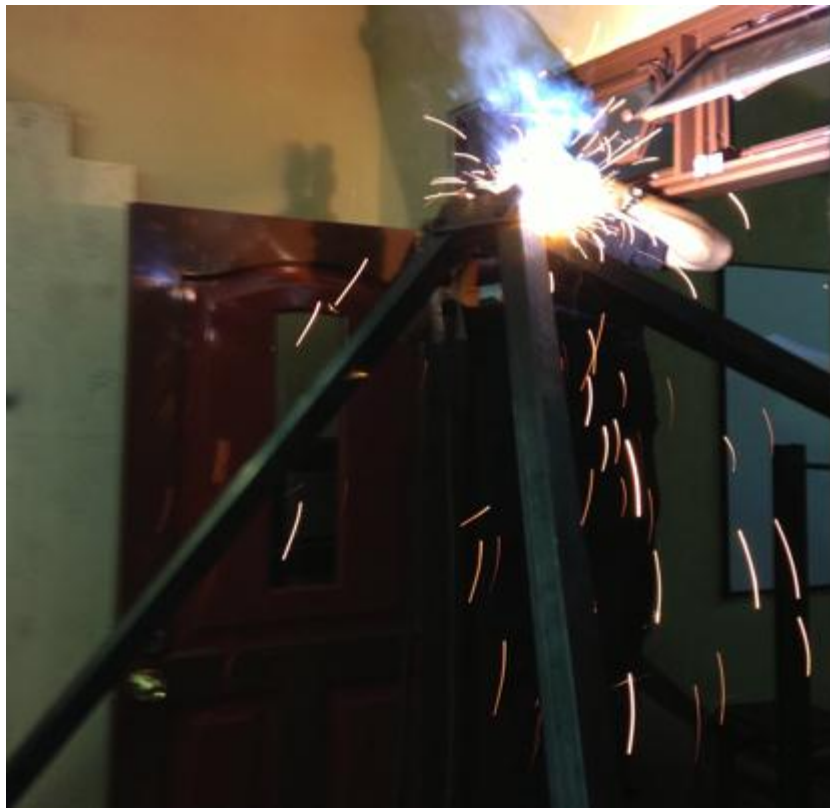
Figura 33.- Soldando los ángulos en la plataforma .
