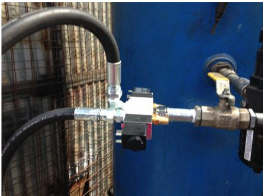
Figura 44.- Conexión electroválvula-compresor.
