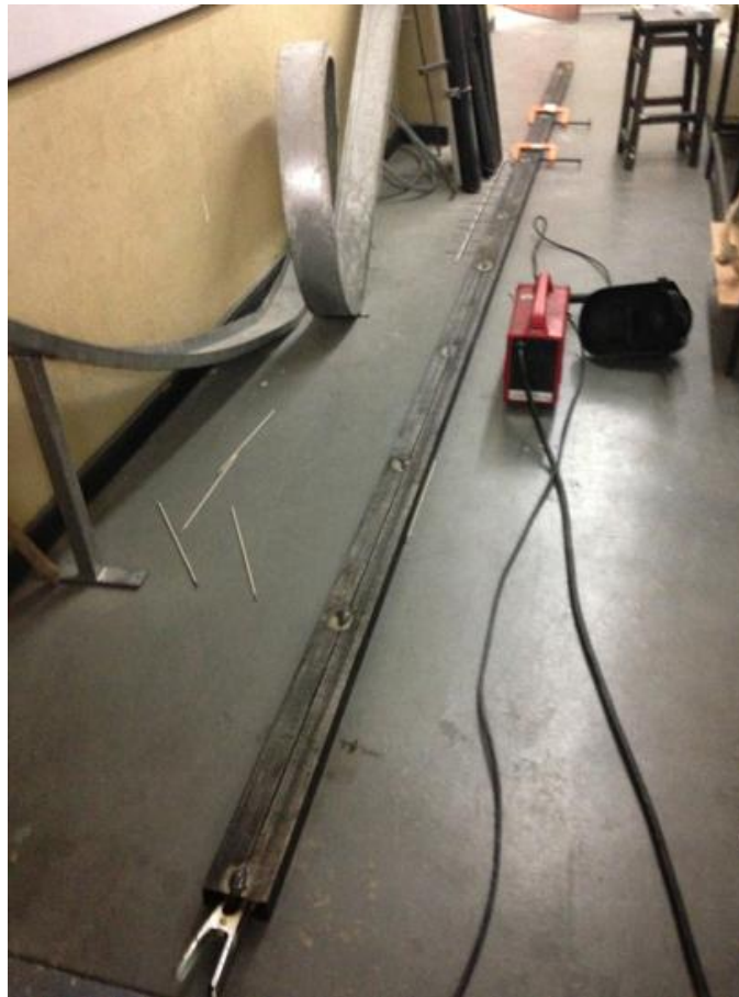
Figura 31.- Perfiles de acero soldados para formar la pista de la plataforma.
