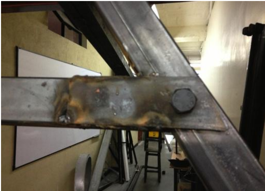
Figura 35.- Platinas soldadas a los travesaños y empernadas a la estructura.
