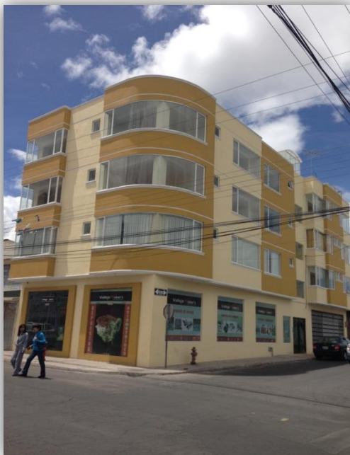
Fotografía 4 Fachada del edificio "Vallejo"
