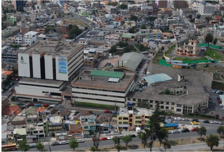
Fotografía 26 Zona 2 Hospital del IESS (skyscrapercity, 2013)
