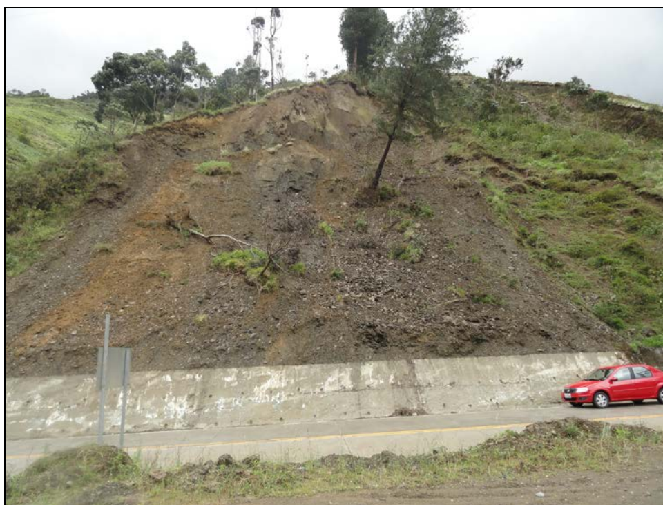
Fotografía No. 4: Detalle de flujos de escombros a un costado de la vía. El material aflorante pertenece a la Formación Chigüinda. UTM: 712102-9560014
