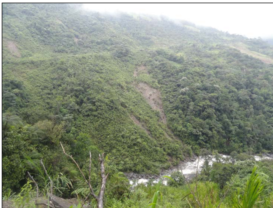
Fotografía No. 8: Detalle de flujos de detritos talud debajo de la vía. El material aflorante pertenece a la Unidad Gneis de Sabanilla. UTM: 719686-9556348
