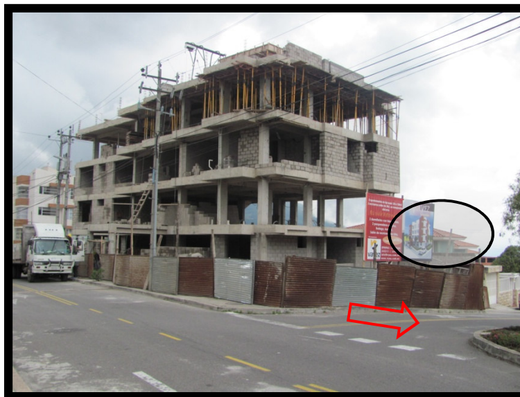
Fotografía 4.6.1. Edificio Vayez Sebastián – Construcción de la estructura Realizada por: Patricio Bonilla
