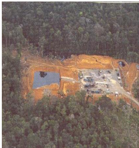
Figura 3 Área en Sushufindi para piscinas de lodos con crudo (contaminación)
