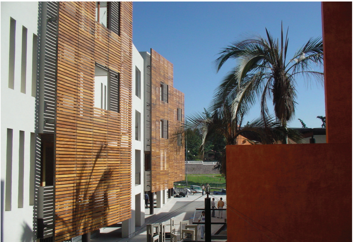
Imagen 68. Vista desde el interior del edificio. Constructiva Arquitectura.
