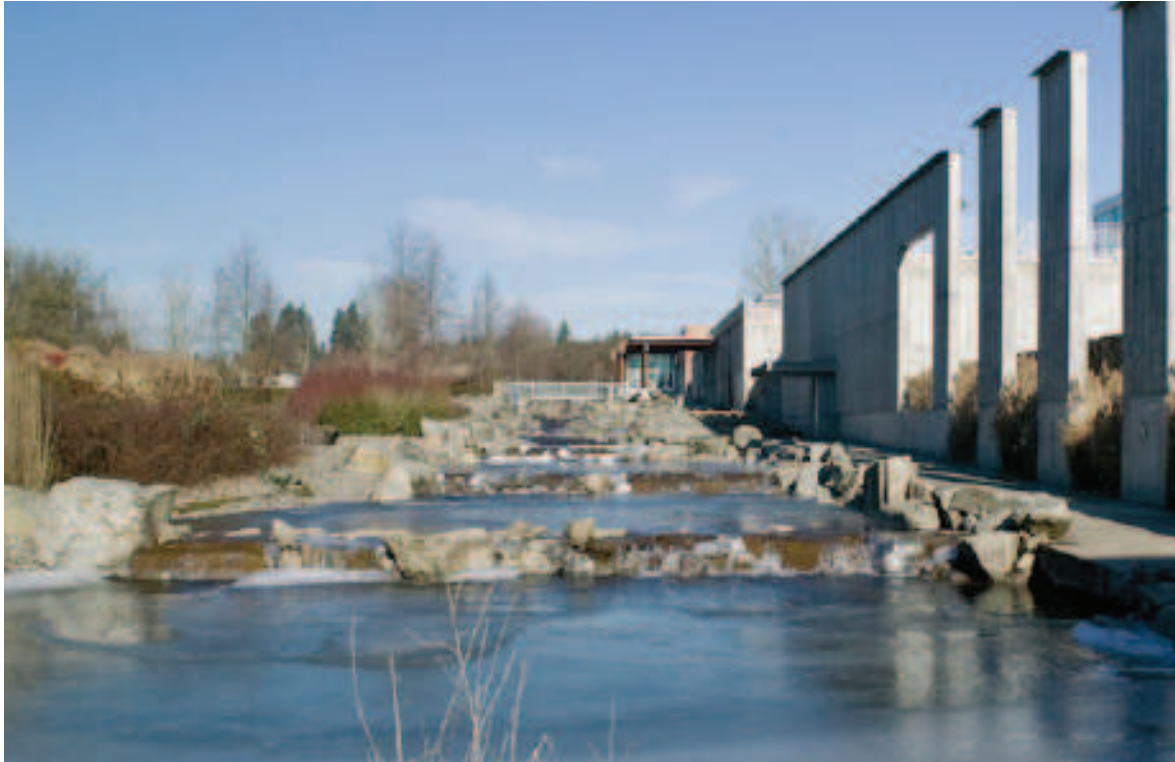
Imagen 80. Vista muro de Horminigon, eje norte sur. Miller & Hull
