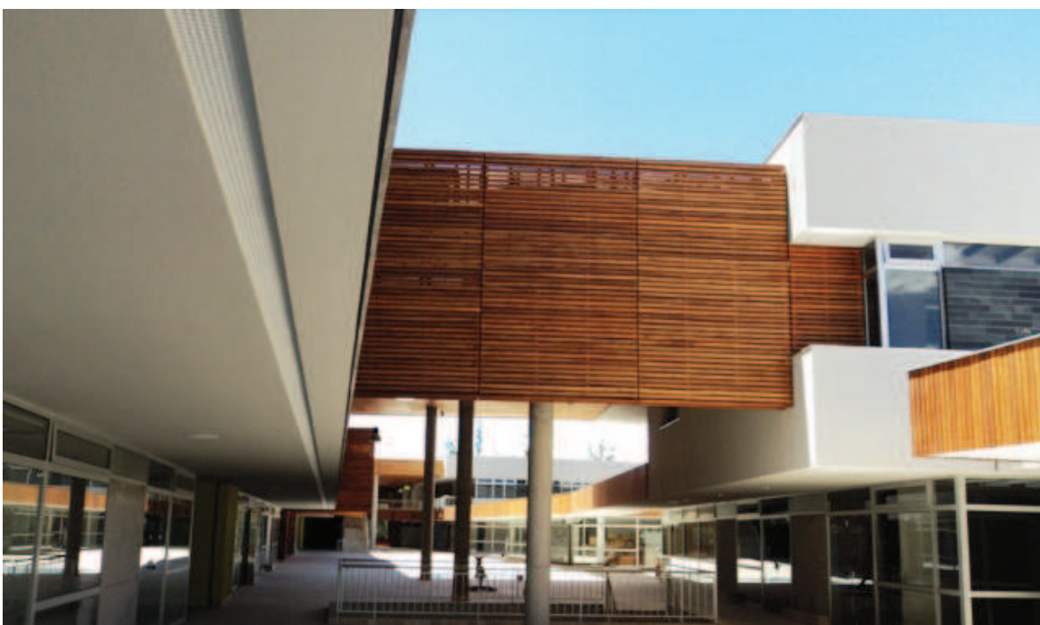
Imagen 73. Vista interior. Proinmobiliaria
