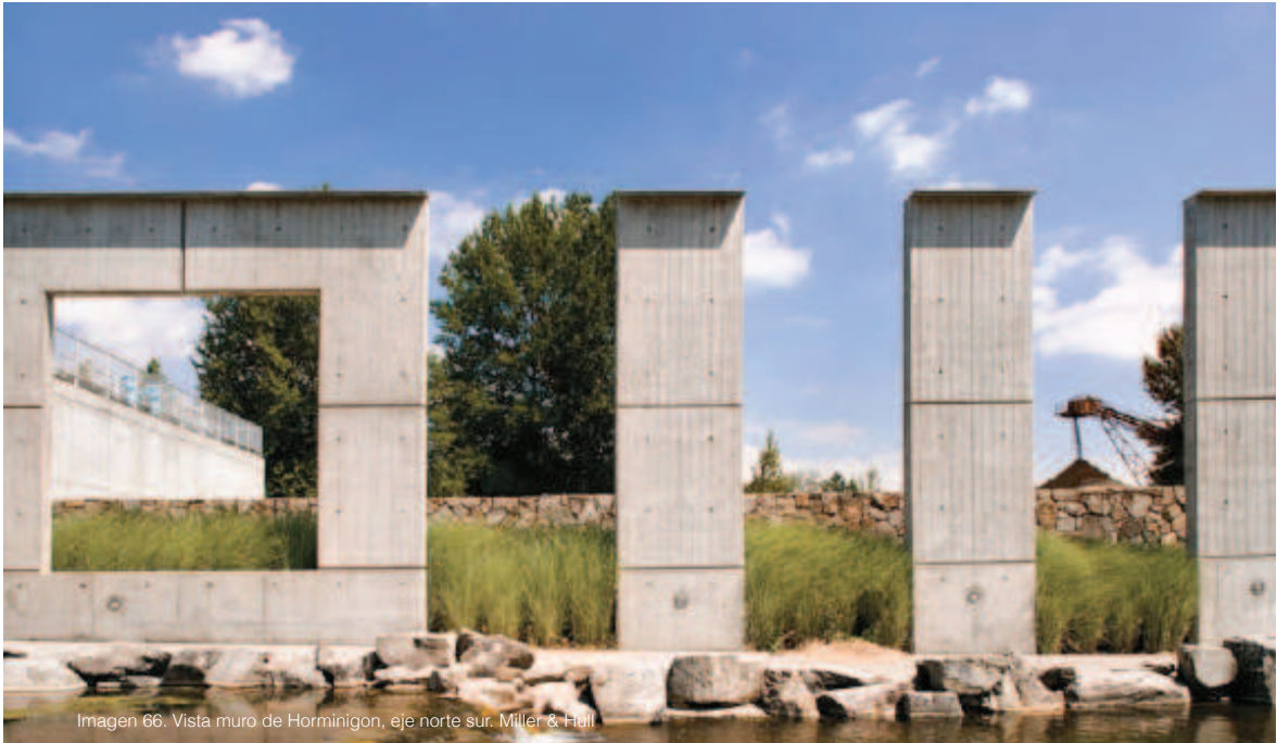
Imagen 76. Vista muro de Horminigon, eje norte sur. Miller & Hull
