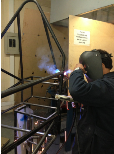
Figura 39: Operador realizando cordones de suelda definitivos en estructura
