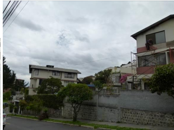
Foto No. 10 Lote con edificaciones vecinas. Fuente: C. Yépez.
