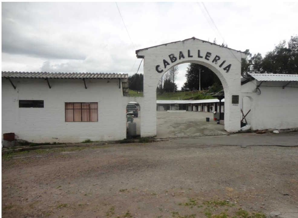
Figura 5. Actual Establo de la U.E.R-Vista Frontal
