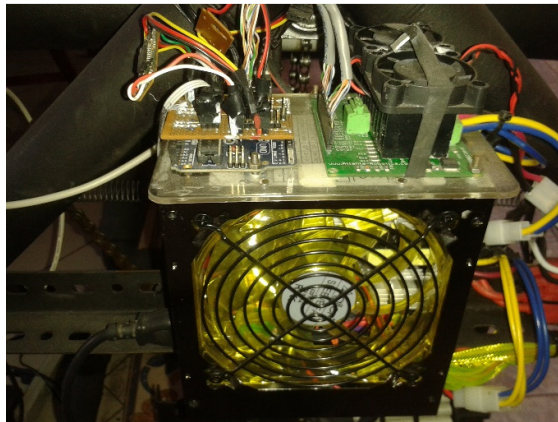
Figura 60: Fuente de alimentación y circuitos
