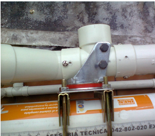
Figura 43: Acople con la base vertical
