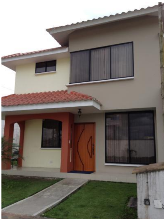
Fotografía 3-9 Fachada casas Proyecto Palma Real
