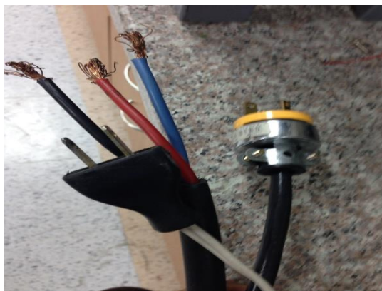
Figura 8: Antigo sistema eléctrico de la máquina de fatiga (Mogollón, 2012)
