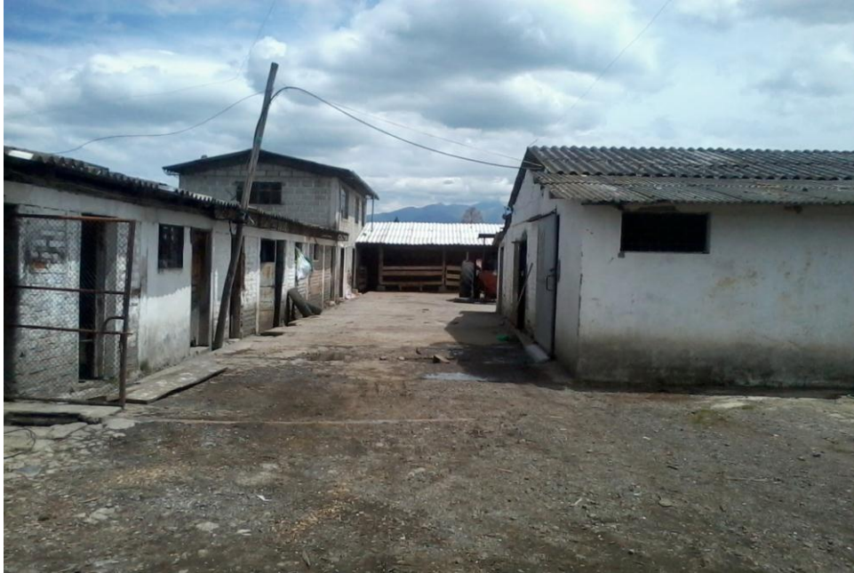
Bodegas a la izquierda, y cuarto de enfriamiento en la parte derecha
