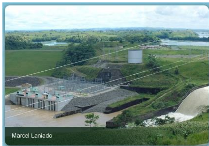
Figura 17 Central Marcel Laniado. Fuente: Hidronacion (2014)
