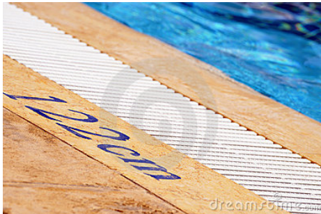
Señalización de profundidad de piscina y utilización de rejillas en el perímetro.
