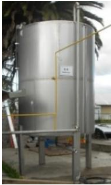
Figura 5.13 Tanque de almacenamiento de biol C-4
