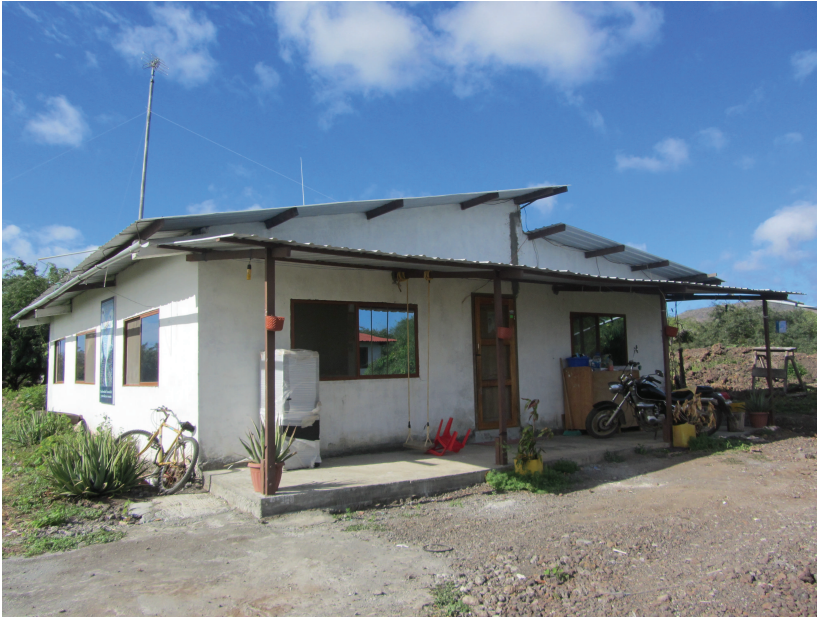
Casa tipo 1, Hormigon, Bloque y techo de Zinc. Construcción ‘formal’
