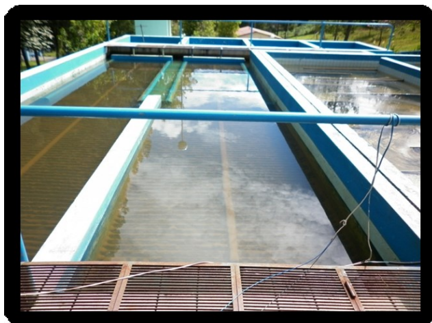
Ilustración 5. Proceso de Potabilización, Piscinas de Sedimentación Sistema de Agua Potable Patamarca Tomada 16/08/2013
