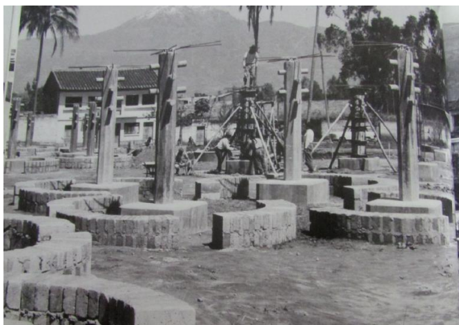
Ilustración 49: Callambas en construcción.
