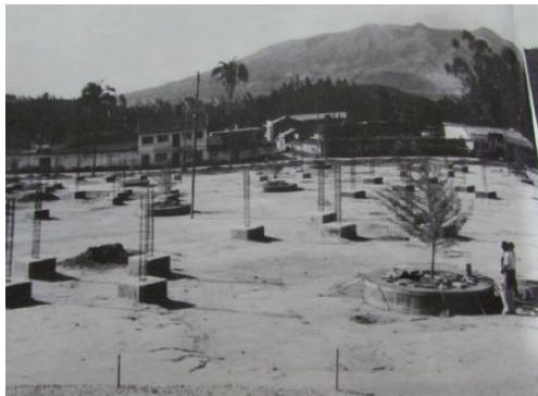
Ilustración 44: Plaza de Ponchos en construcción.
