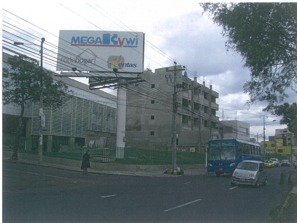
IMÁGEN 3.1.: AVENIDA PRINCIPAL (ELOY ALFARO) DE INGRESO AL SECTOR
