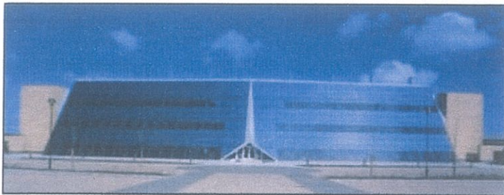
Fig. 20 Studio E, Oficina solar Doxford. Piel de fachada conformada por paneles fotovoltaicos 1
