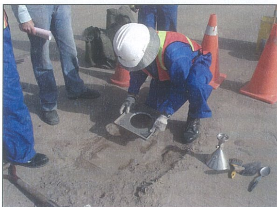
Figura 3.3.- Nivelación del terreno.
