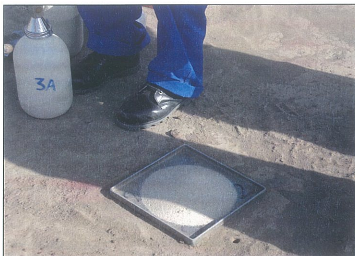
Figura 3.9.- Plato base y arena una vez retirara la botella con arena.
