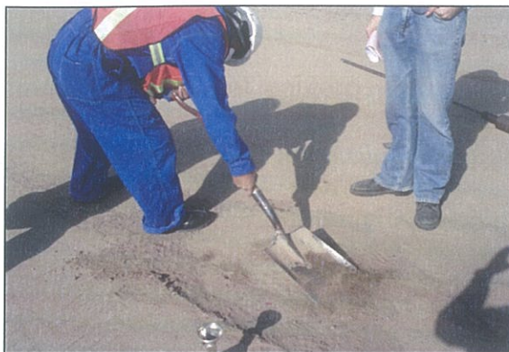
Figura 3.2.- Nivelación del terreno.
