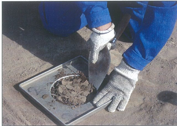
Figura 3.5.- Excavación del agujero.
