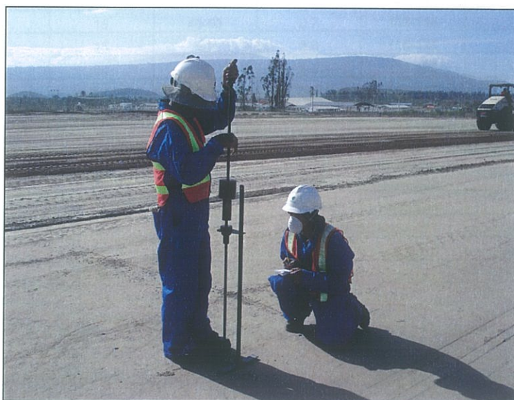
Figura 3.18.- Realización del ensayo DCP.
