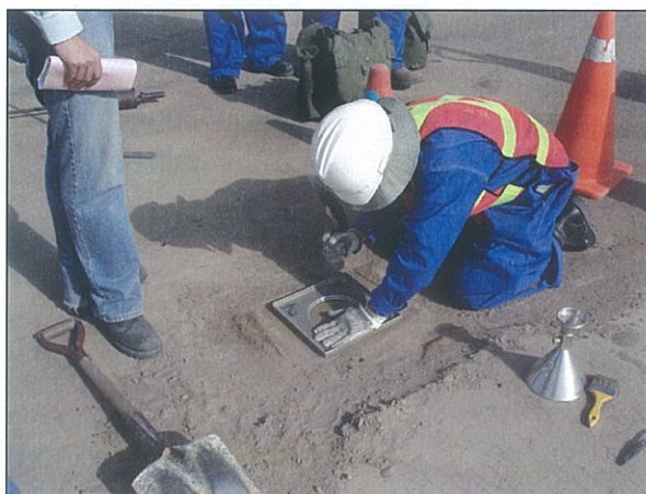
Figura 3.4.- Colocación y aseguramiento del plato base.
