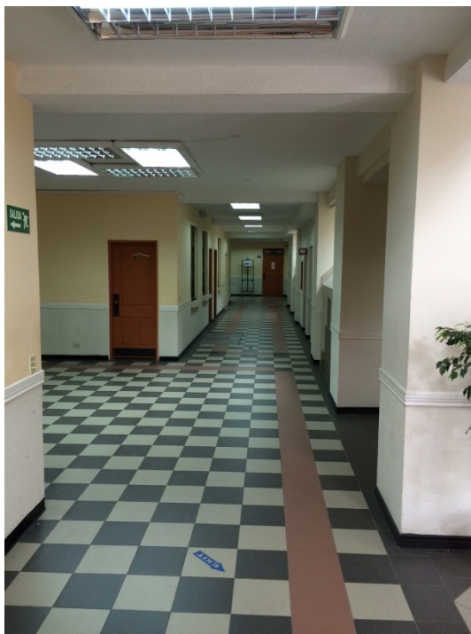
Imagen No. 35.- Luminarias en pasillos, que permanecen encendidas durante el fin de semana.
