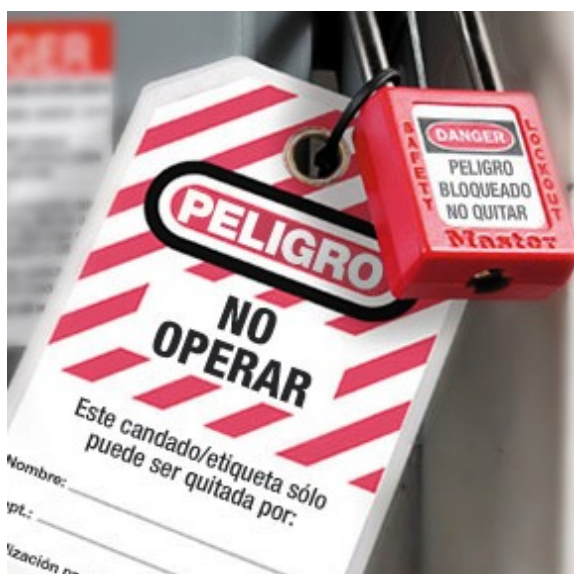
Imagen No. 12.- Candado y etiqueta en caja de interruptores.
