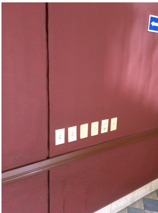
Imagen No. 37.- Interruptores en los que se pueden adaptar temporizadores.
