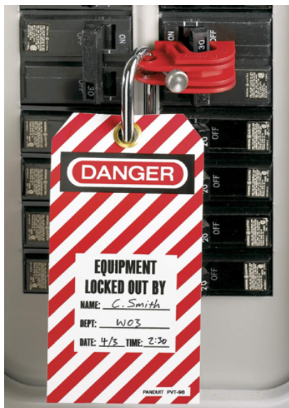
Imagen No. 11.- Candado y etiqueta en “Breakers”.
