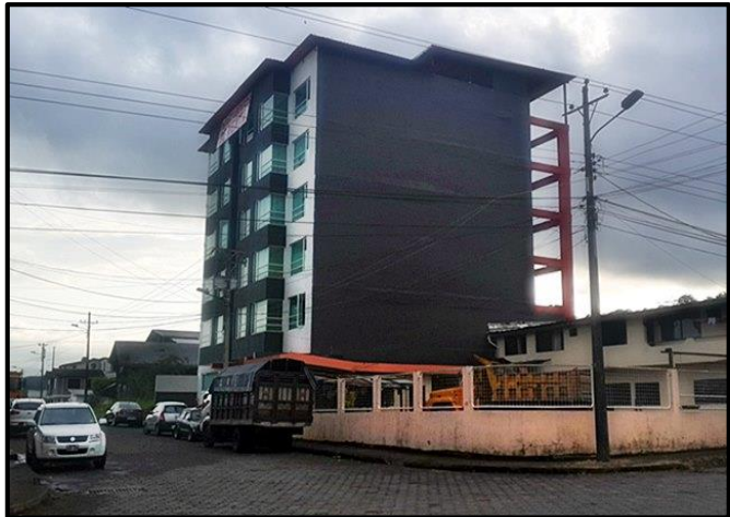
Imagen 24 Oferta 003 Edificio El Dorado Fuente: Levantamiento en Campo 2014 Elaborado: David Álvarez
