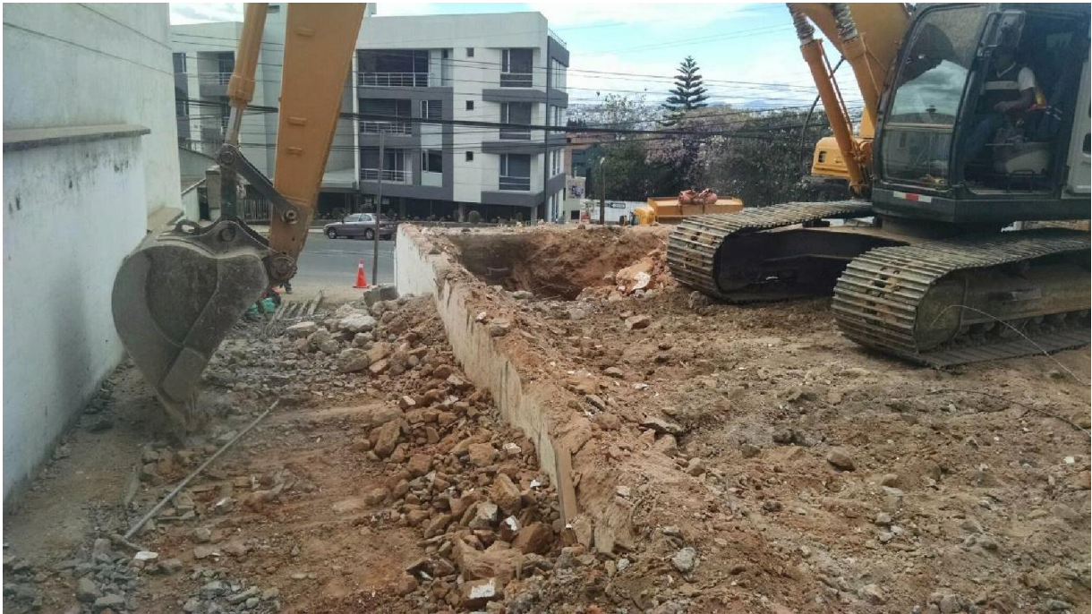
Ilustración 5-2 – Imagen posterior del terreno en el momento del derrocamiento de estructura existente
