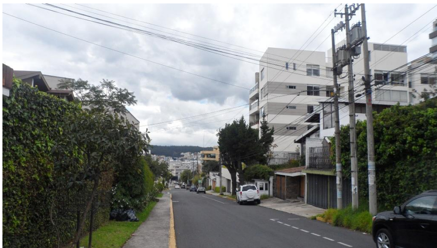
Fotografía 2 6 Vía de acceso Mariano Echeverría en el Edificio Leganz Plaza. ( Julio 2014)
