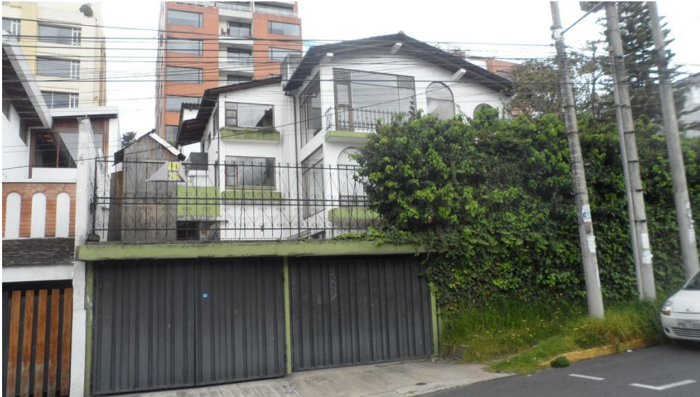
Fotografía 2 3 Terreno para Proyecto Edificio Leganz Plaza
