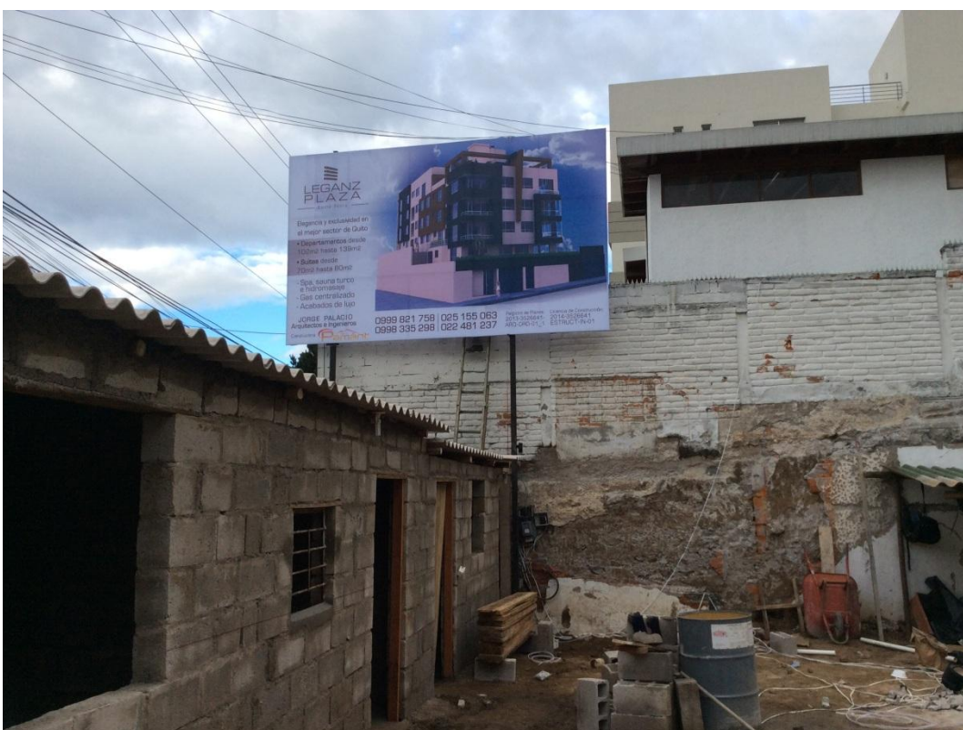
Fotografía 3 10 Edificio Leganz Plaza
