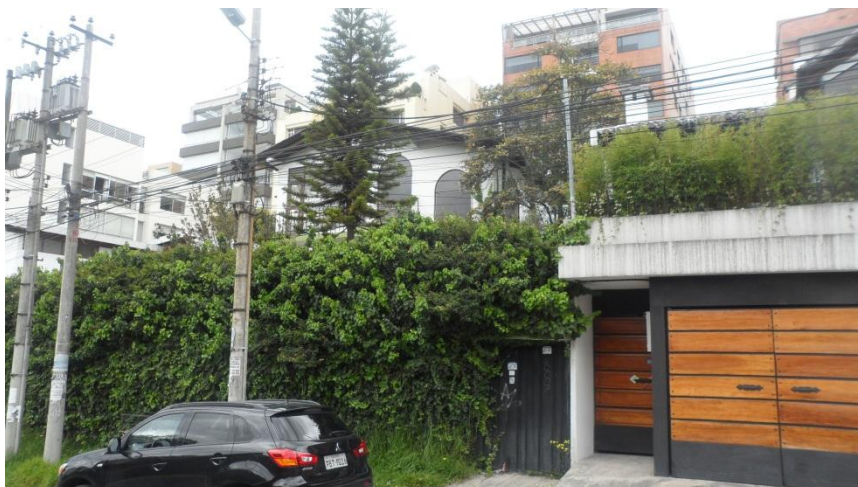
Fotografía 2 7 Poste de Luz Eléctrica
