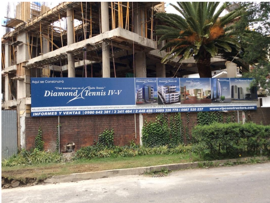
Fotografía 3 8 Competencia Edificio Diamond Tennis IV y V
