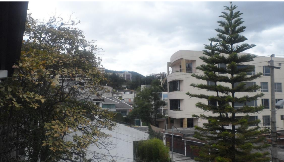
Fotografía 2 5 Vista Noroeste del Proyecto Edificio Leganz Plaza.
