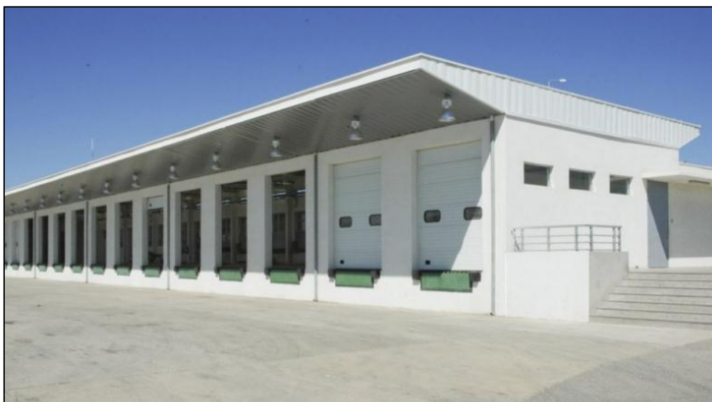
Figura N° 8-10: Vista Exterior N°2 Andenes de Inspección Puerto Valparaíso
