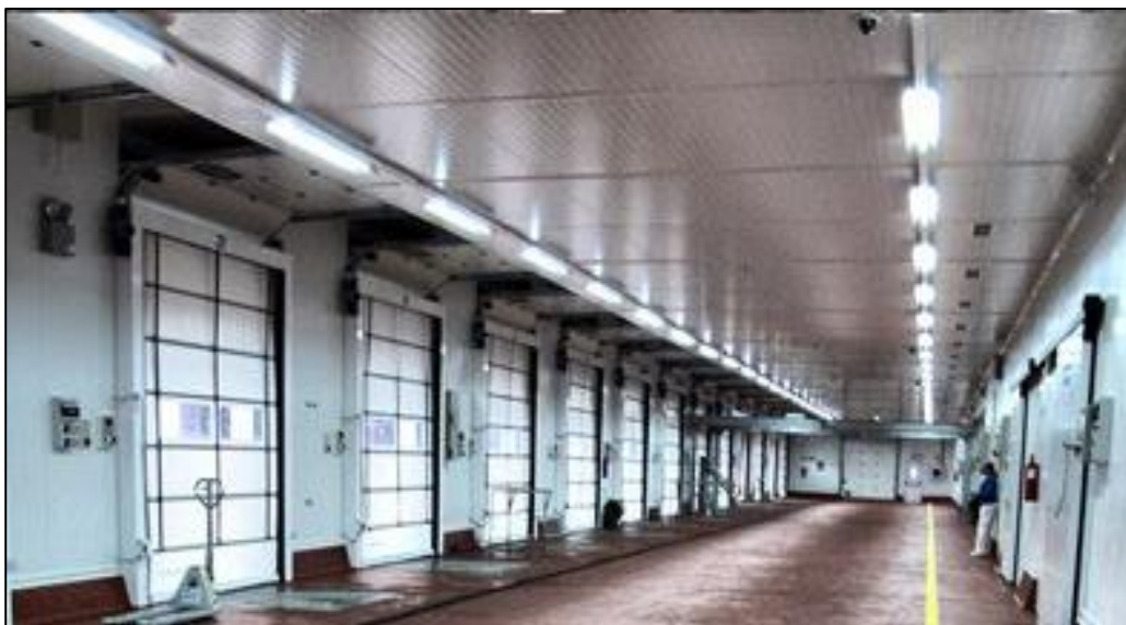
Figura N° 8-7: Vista Interna Zona de Inspección - APBA
