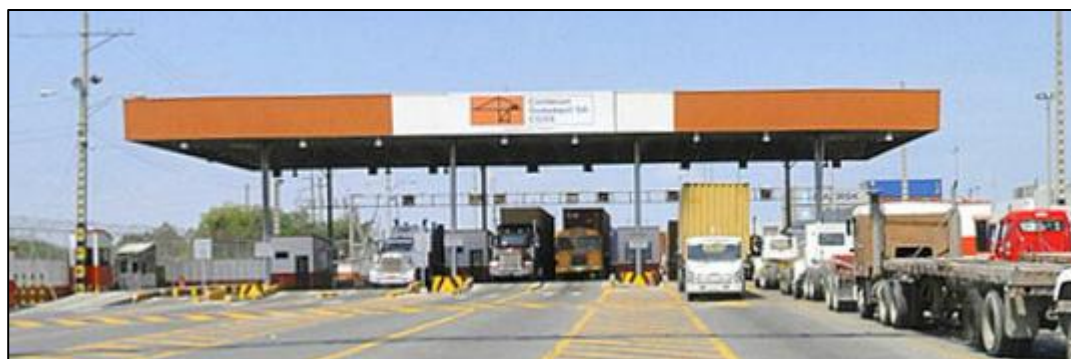
Figura N° 6-18: Vista N°2- Garita de Entrada de Contenedores Contecon S.A.
