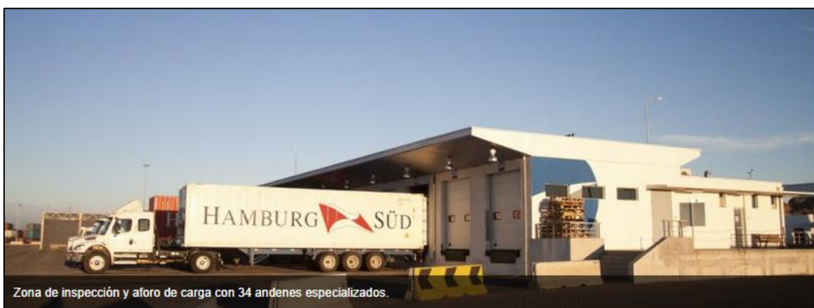
Figura N° 8-9: Vista Exterior N°1 Andenes de Inspección Puerto Valparaíso
