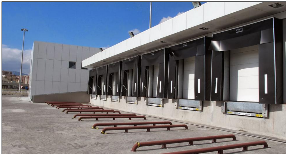
Figura N° 8-6: Muelles descarga reformados para mercancías vegetales
