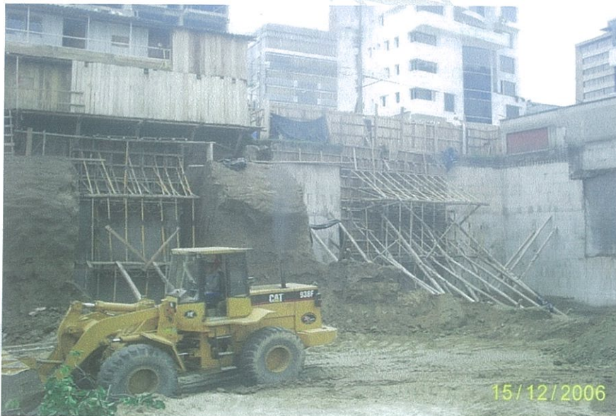
Fotografía 4.1 Excavaciones y muros anclados
