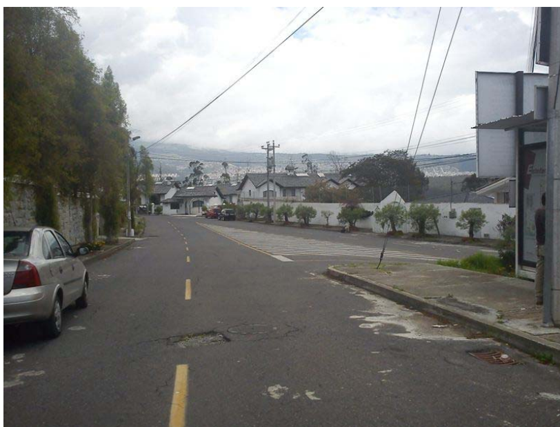
FOTOGRAFIA 7- VISTA CALLE CORDERO
