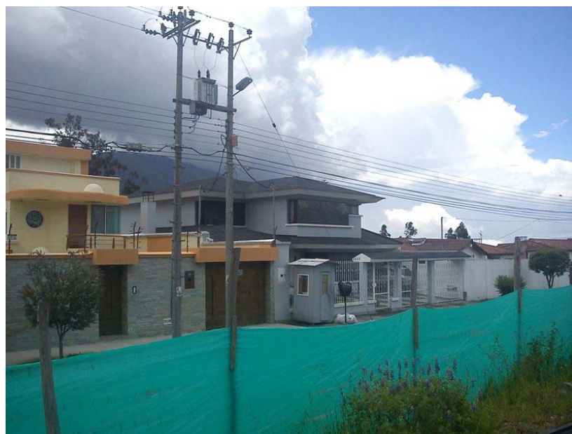
FOTOGRAFIA 5- VISTA CALLE JOSE ORDOÑEZ 2
