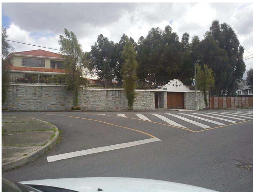
FOTOGRAFIA 6- VISTA INTERSECCION CALLE ORDOÑEZ Y CORDERO
