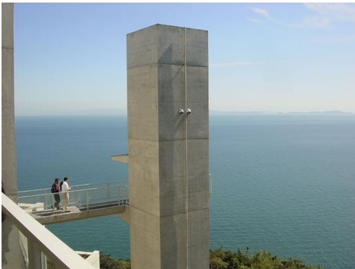
Imagen 51. Vista exterior de ascensor.
