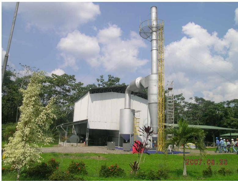
**Lavador de gases, Ciclón Húmedo, Chimenea.**
