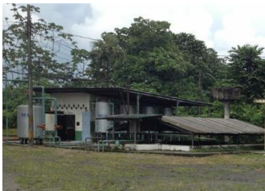
Anexo 2. Tanque de agua de almacenamiento para alimentar a los calderos
