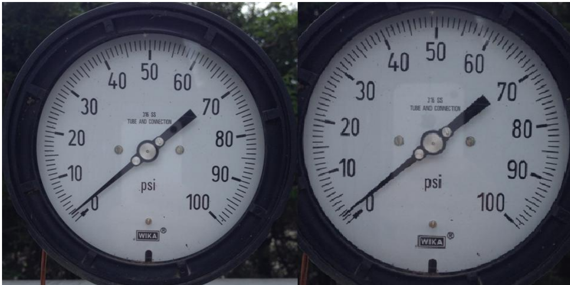
Figura 4.13: Prueba de fugas en la bala de biogás
