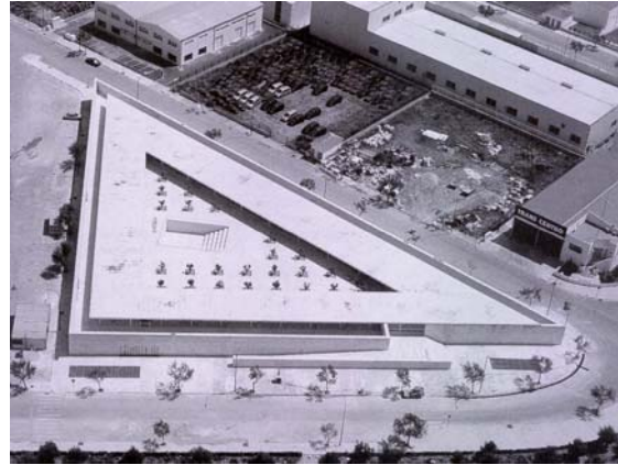
Foto del Conjunto y Foto que evidencia la dilatación entre la cubierta y el muro perimetral
