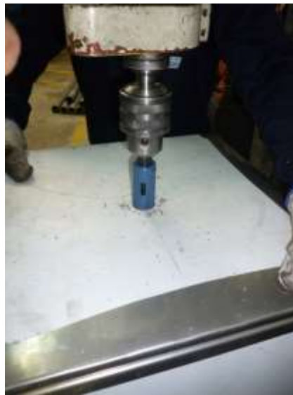
Figura 4.22: Realización de agujeros en la estructura
