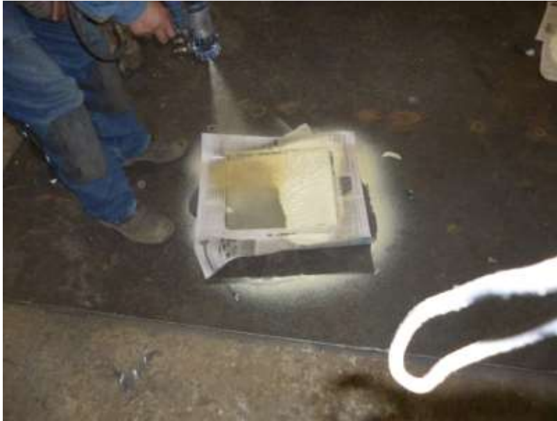
Figura 4.14: Inyección del poliuretano
