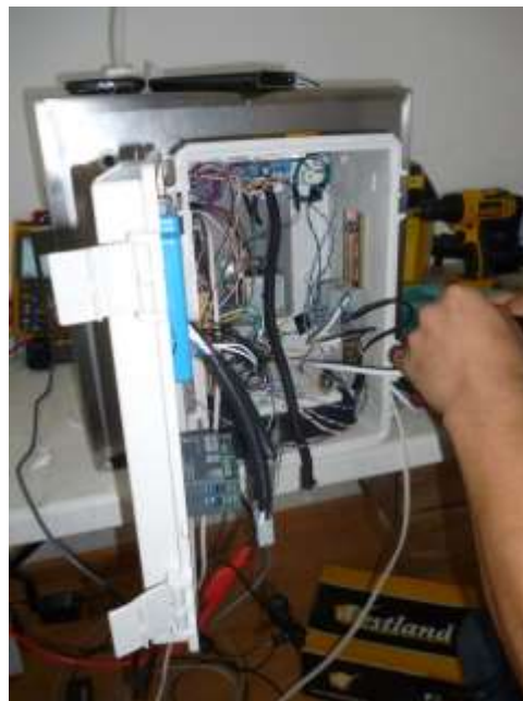
Figura 4.24: Instalación de la caja de control
