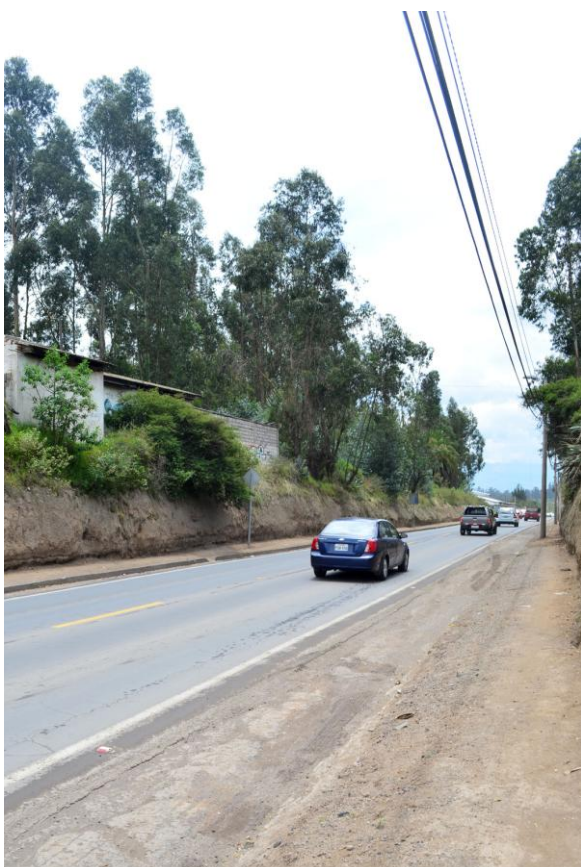
Fig: 5-91 (Ilustración propia) Vía principal
