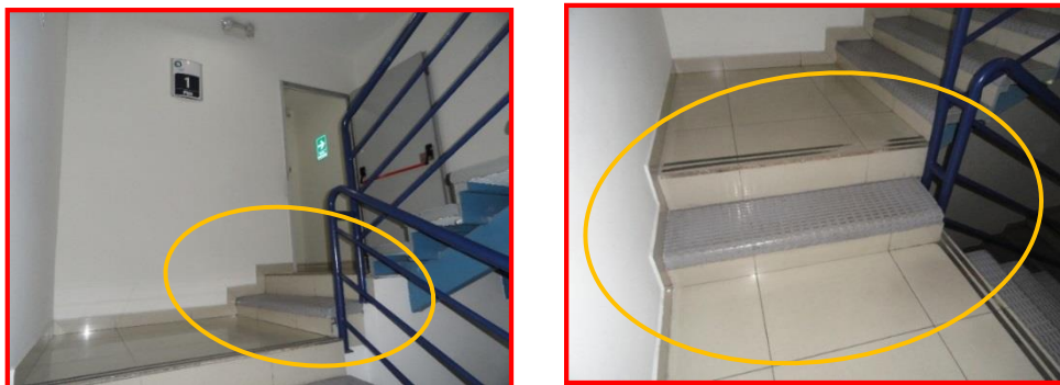
Fotografía 23. Conformación de descansos de las gradas de emergencia (presurizadas)
