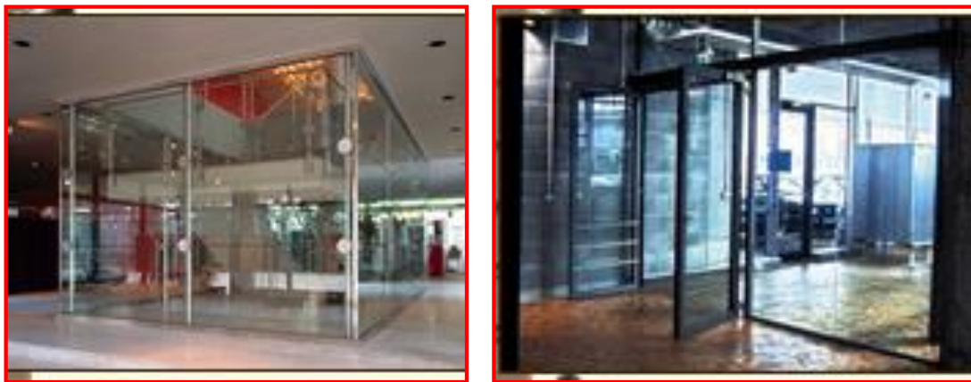
Fotografía 10. Particiones vidriadas
