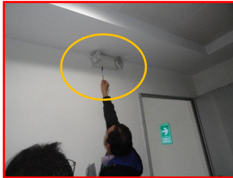
Fotografía 24. Prueba de lámparas de emergencia en gradas de emergencia
