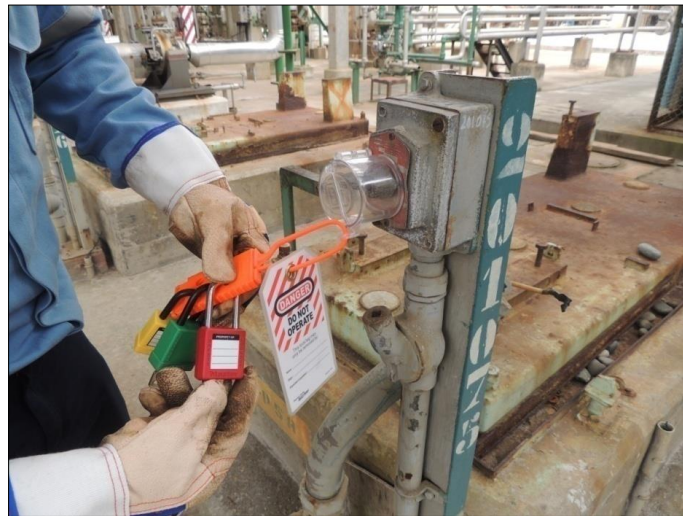
Figura 4-3. Bloqueo Mecánico Rotativo
