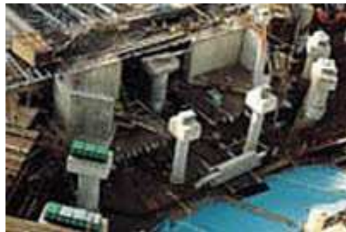
Fig. 5: Cimentación sobre almohadillas elásticas
