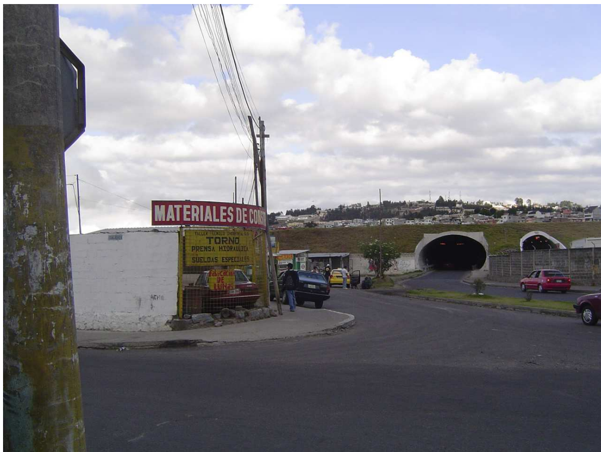
Fig. 28: Vista de los túneles
