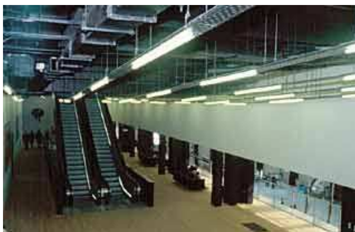
Las gradas eléctricas como la circulación principal entre pisos
