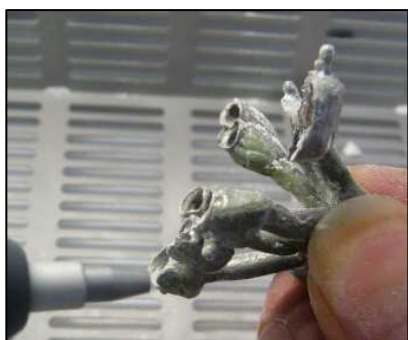
Figura 55. Colado del metal.
