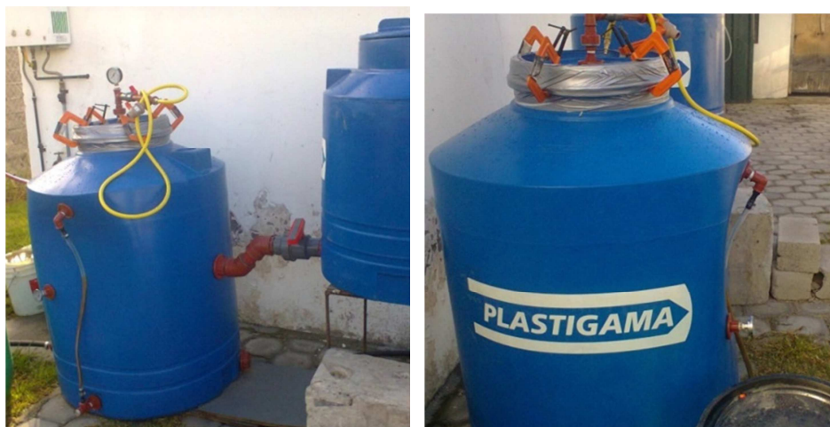
Figura 4.5 Presión negativa generada en el biodigestor, ayuda a destapar tuberías
