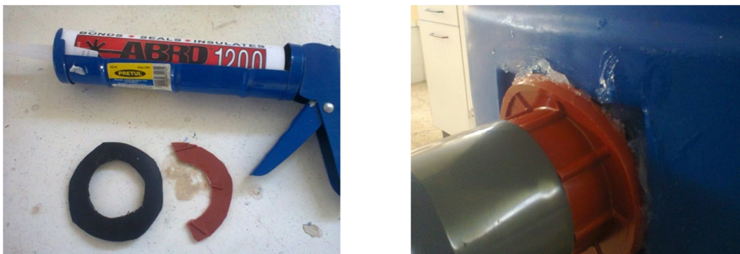
Figura 3.14 Sellantes y juntas utilizados en los adaptadores
