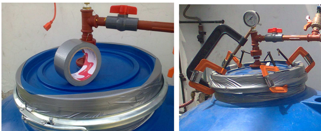
Figura 3.20 Adecuaciones para reparar el seguro de la tapa del digestor
