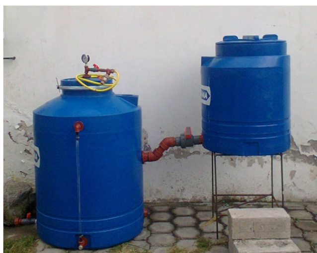
Figura 3.18 Sistema listo para pruebas de hermeticidad del digestor
