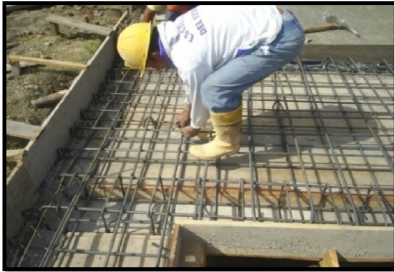
Fotografía 1 – Superficie de hormigón reforzado en Simulador (ADC&HAS, 2006)
