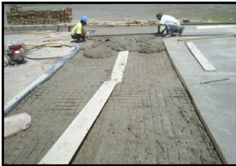
Fotografía 2– Superficie de hormigón reforzado en Simulador (ADC&HAS, 2006)
