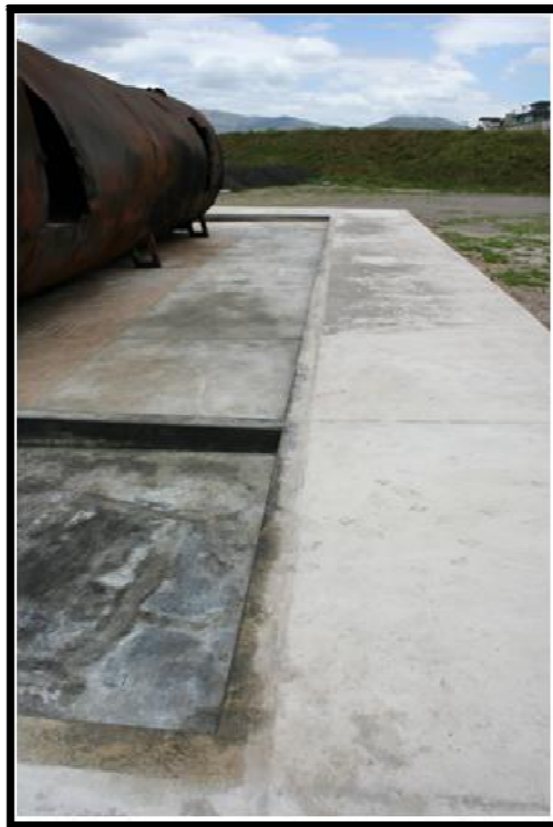
Fotografía 6 – Vista sur lado este del Simulador de Incendios (ADC&HAS, 2006)
