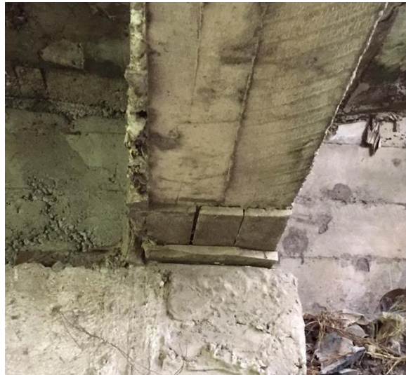
Figura 26. Rodamiento sobre pila B en viga 3
