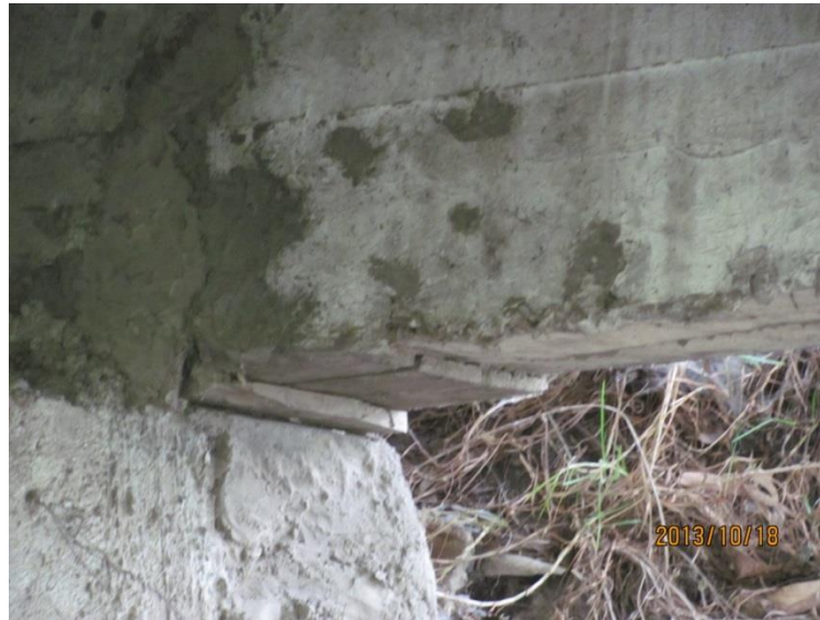
Figura 45. Mala Elección de Materiales (Rodamientos)
