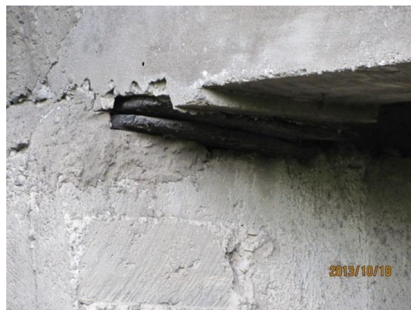
Figura 25. Rodamiento Sobre Pila B en
