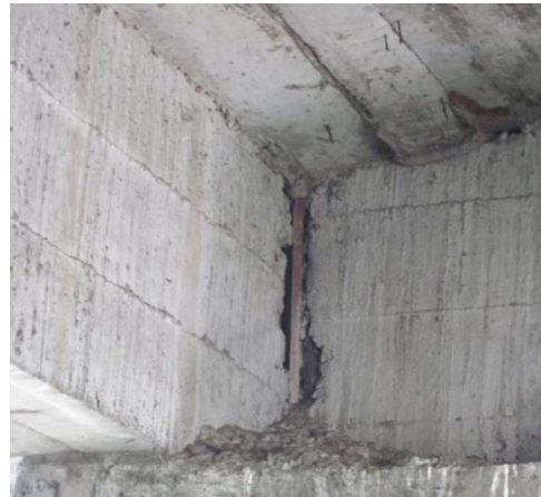
Figura 41. Exposición de Acero en Unión
