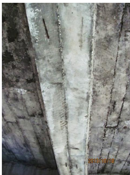
Figura 19. Exposición del Acero en Viga 2
