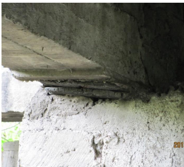
Figura 24. Rodamiento Sobre Pila B en
