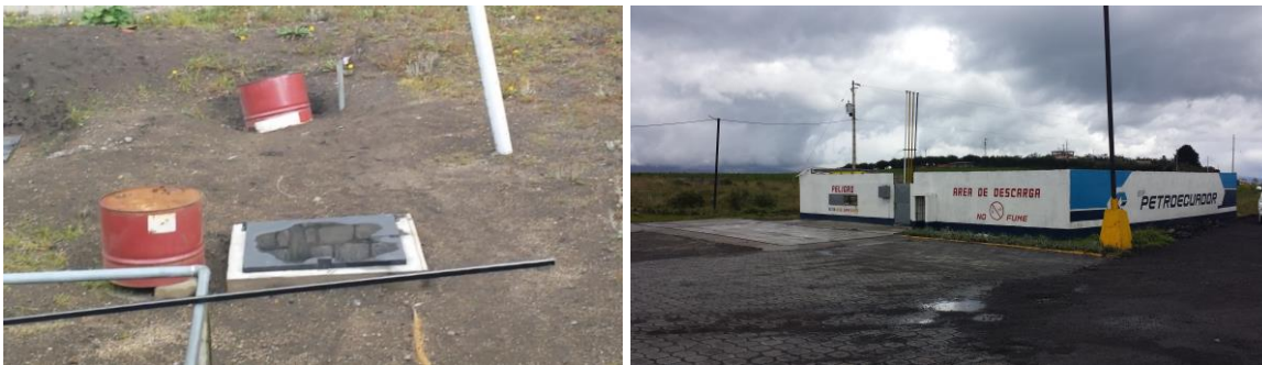
Ilustración 5: Tanques de almacenamiento Fuente: autor
