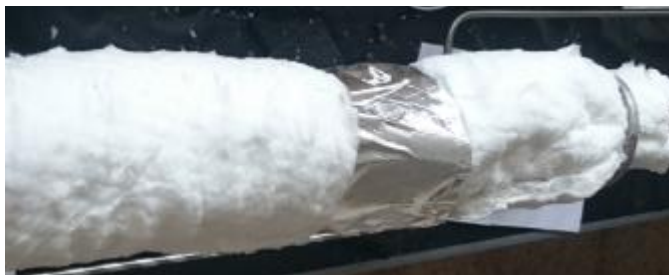
Figura 3.3: Cubierta de fibra cerámica alrededor de la niquelina
