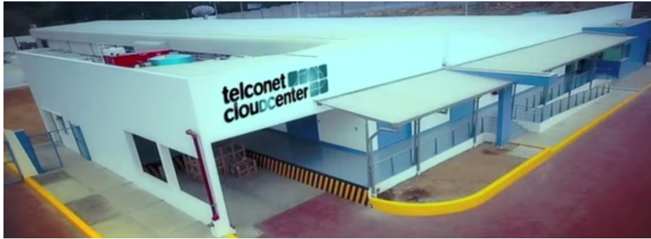
Ilustración 1. Vista externa del Cloud Center de Telconet (Telconet S.A., 2015)
