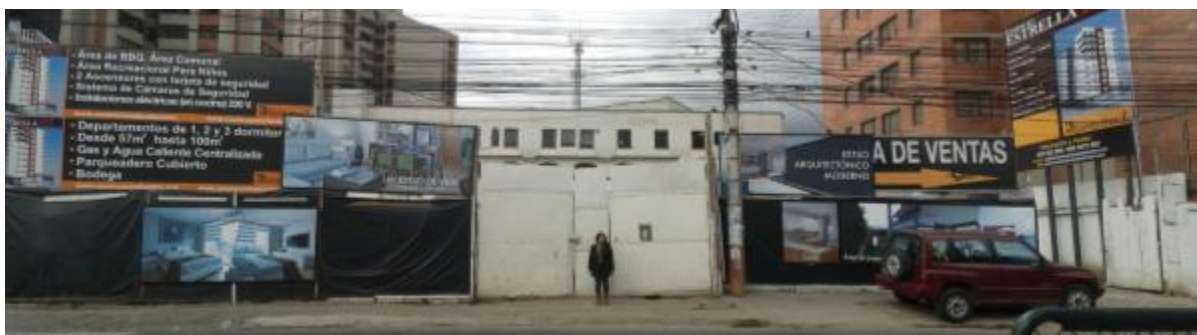
Fotografía 1: Predio del Edificio Estrella VIII Elaboración: Carolina Bravo Faz
