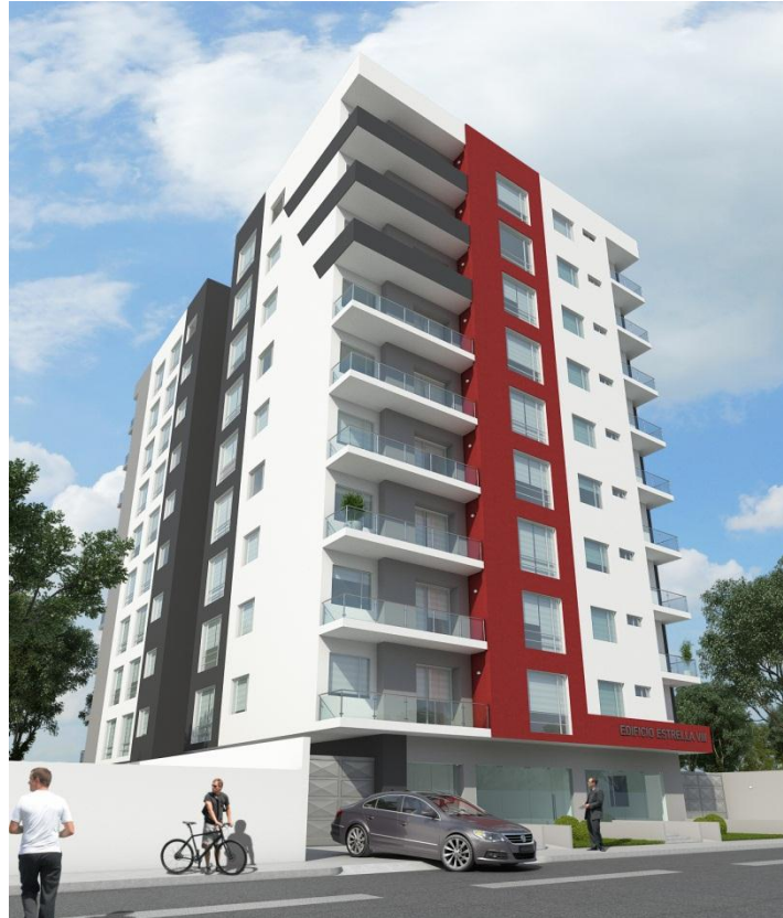
Gráfico 44: Remate Edificio Estrella VIII Fuente: Constructora Estrella Viteri Elaborado: Constructora Estrella Viteri
