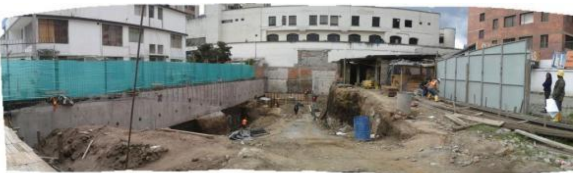
Fotografía 2: Estado de Avance del Proyecto Elaboración: Carolina Bravo Faz
